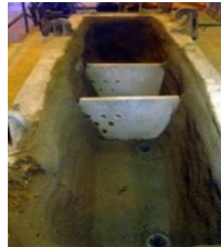
Evolutia temperaturilor la uscarea distribuitorului forcretat (iarna) Fig. 2. Tundish with shotcrete
