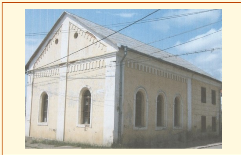
Foto 4 - Sinagoga din Gura-Humorului
