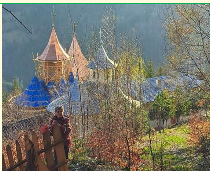
Lângă schitul din lemn se construiește o biserică nouă, solidă
